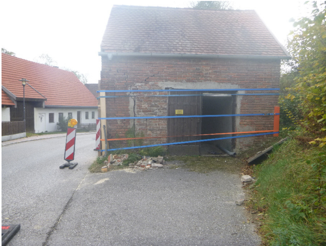
Aufnahme vom 26.10.2018, Staatliches Bauamt Freising
