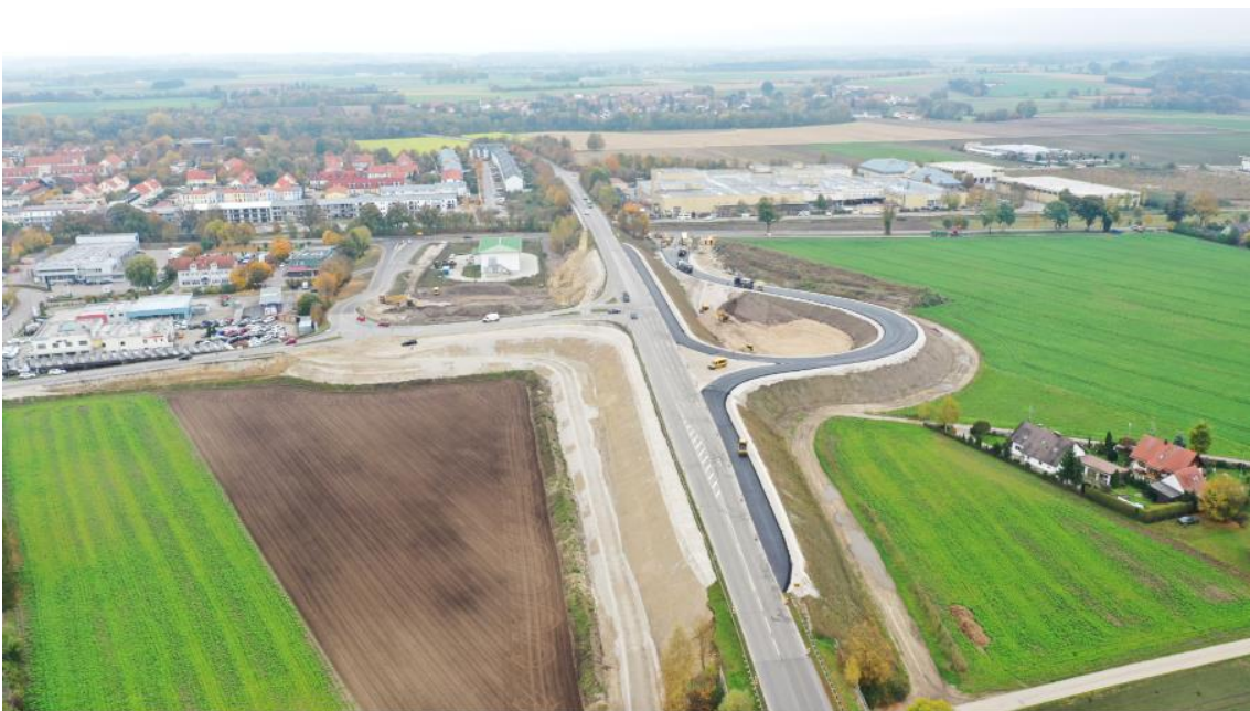
Ehemalige Abfahrtsrampe zum Gewerbegebiet Erding Südwest und Schloßallee (St 2082) sowie Anbau der Südrampe an die B 388 (Oktober 2019)
