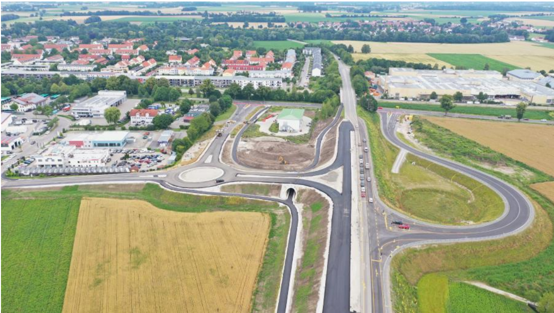
Einbau eines Kreisverkehrs in die Nordrampe sowie Anbau der Nordrampe an die B 388 (Juli 2020)
