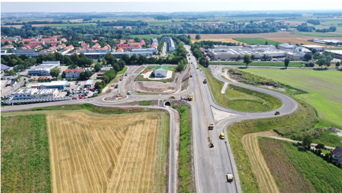
Einbau der Mitteltrennung in die B 388 sowie Restarbeiten unter Vollsperrung (August 2020)
