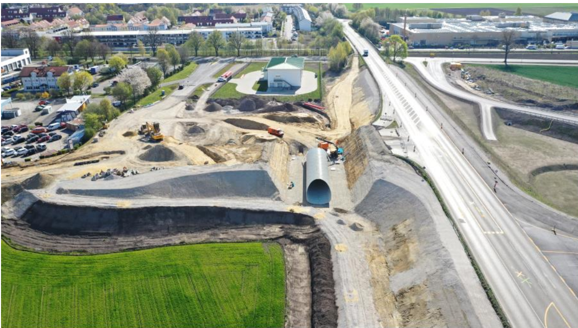
Durch den Wellstahldurchlass führt künftig der Geh- und Radweg (April 2020)
