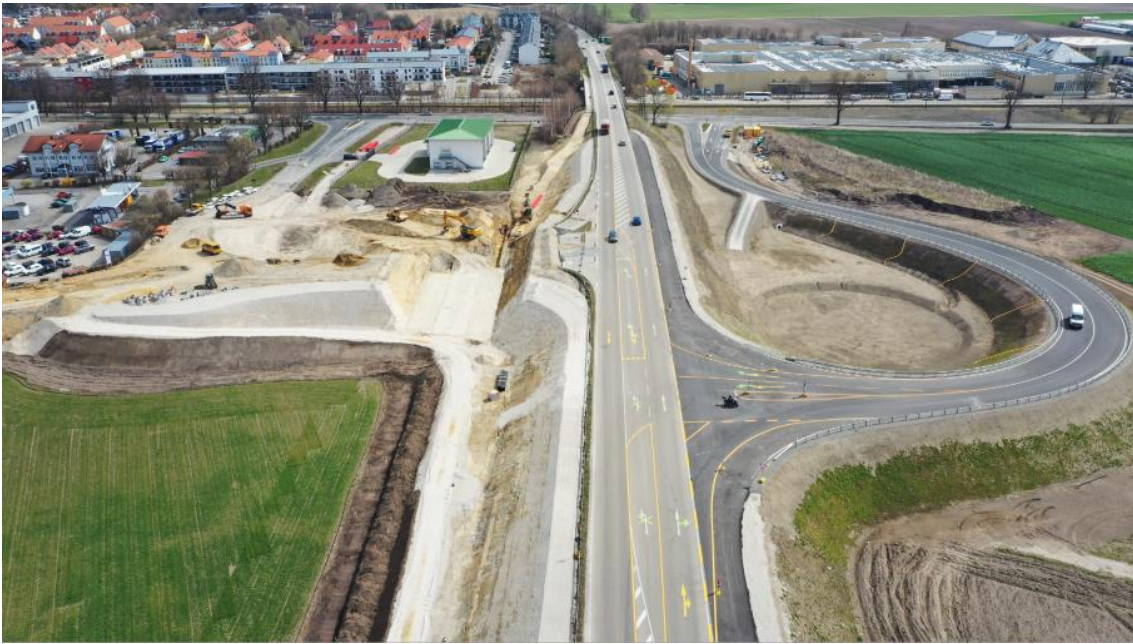
Umbau der nördlichen Rampe, noch ohne Durchlass für den künftigen Geh- und Radweg (März 2020)
