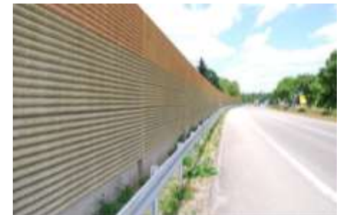
St 2078, Lärmschutzwand bei Brunenthal
