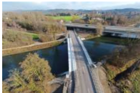
St 2054, MIAG-Kanalbrücke bei Aich
