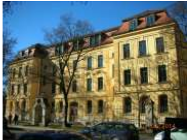
Fachbereich Straßenbau in München-Schwabing
