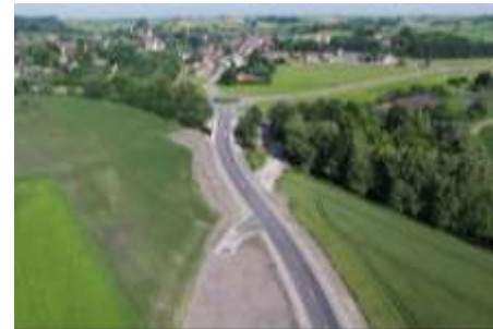
St 2341, Ausbau südlich Massenhausen
