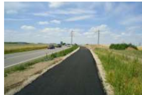
B 13, Geh- und Radweg zw. Maisteig und Fahrenzhausen
