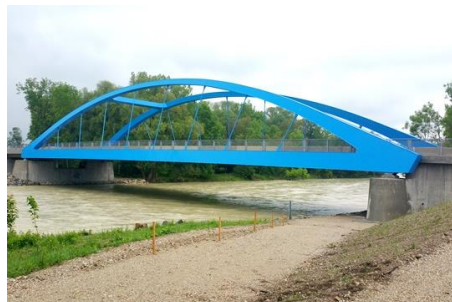
St 2350, Isarbrücke Moosburg a. d. Isar
