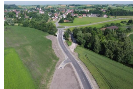
St 2341, Ausbau südlich Massenhausen
