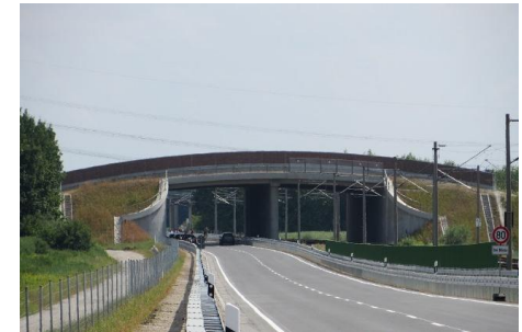
B 301, Ismaning - Hallbergmoos, Grünbrücke
