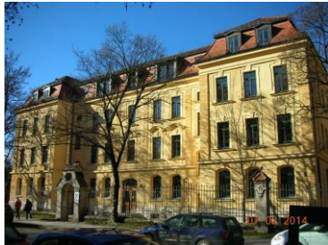
Fachbereich Straßenbau in München-Schwabing
