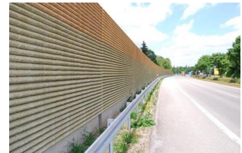
St 2078, Lärmschutzwand bei Brunenthal
