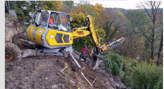
Beispielbild Bauausführung Bohren Bodennägel mit Schreitbagger
